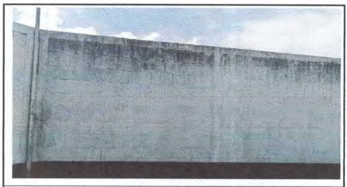
Foto 6: Se muestra fotografía del muro de circulación de la escuela que la pintura de ha desgastado por las inclemencias y el pasar del tiempo tanto en el interior como exterior. El área a pintar es de 144 Mts.2
