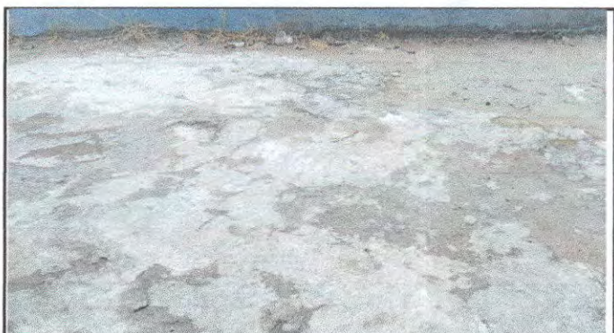
Foto 12: Se muestra fotografía de un área del centro educativo donde la pancha de concreto se ha deteriorado y se encuentra en un mal estado, el área a cambiar es de 63 Mts.2
