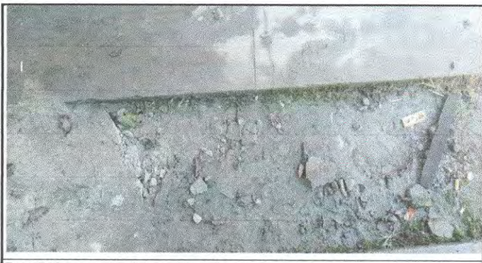
Foto 5: Se muestra fotografía de la cuneta que por el pasar de los años se a dañado en su totalidad y el agua ya no tiene puede circular y el agua se repila en el patio. El área a cambiar es de 30 Mts L.
