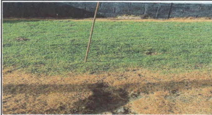
Foto 9: En esta área se encuentra una fosa séptica que es para almacenar los desechos de los servicios sanitarios y ya cuenta con 8 años que no se le ha brindado el baseado correspondiente.
